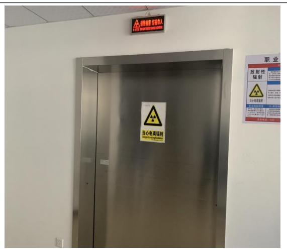
机房南侧病人通道
